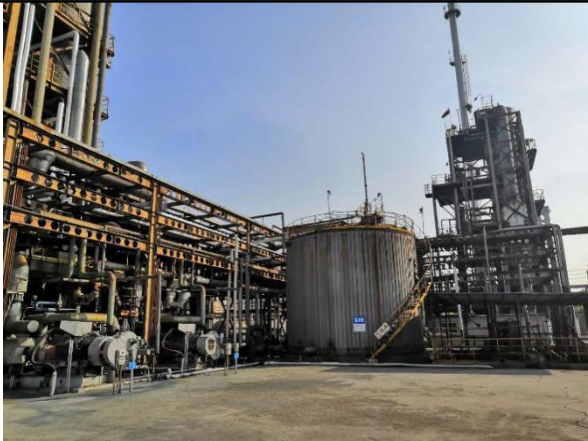
东侧现有富液槽
